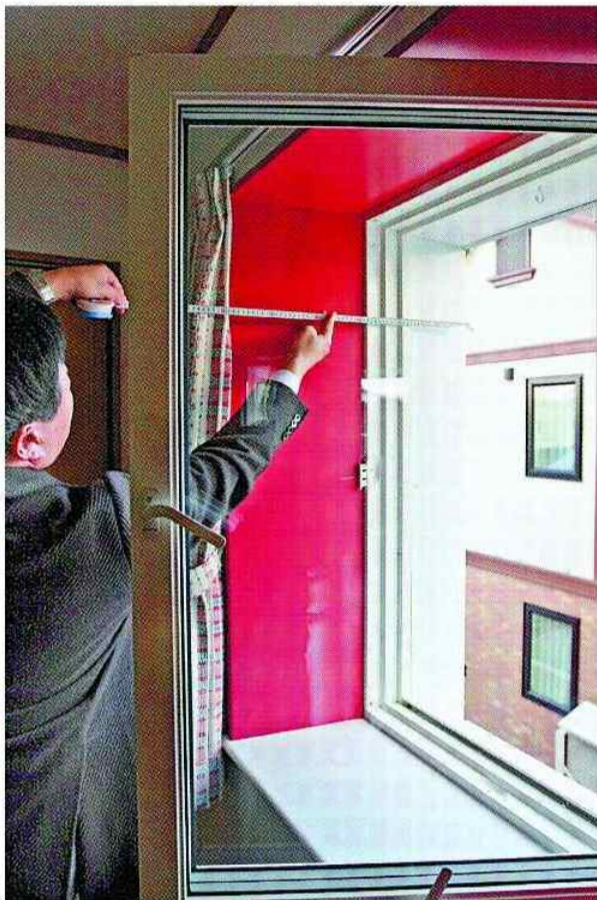
46センチの断熱材が入った、今川さんの建築事務所の壁(茂忠信撮影)
